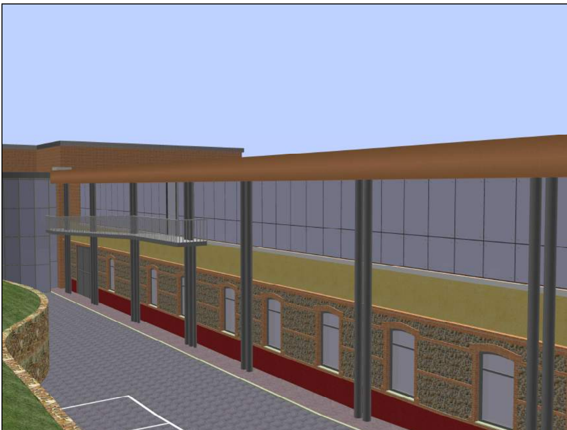
Sopraelevazione edificio artigianale-commerciale a Santorso
